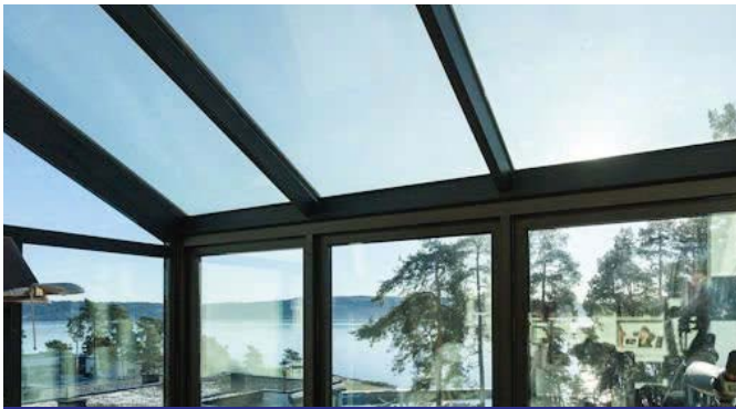
Mái kính - Glass roof
